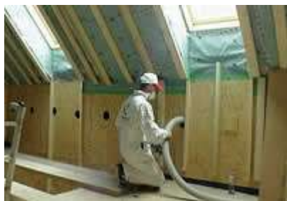
Figura 6. Izolație cu cănepea
