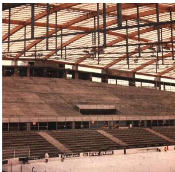
Figura 8. Structură de rezistență în lemn.
